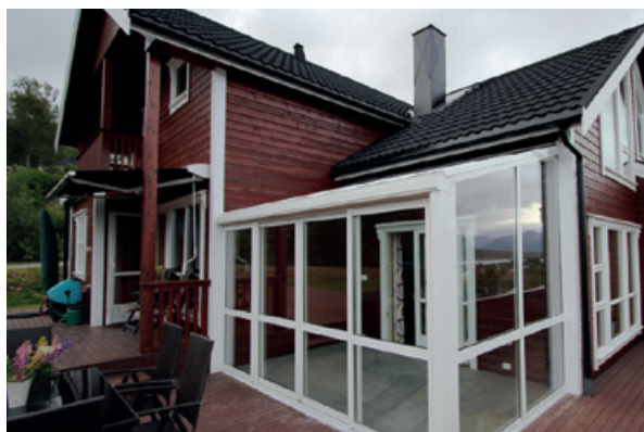
Etter noen få dager er monteringsarbeidet ferdig
